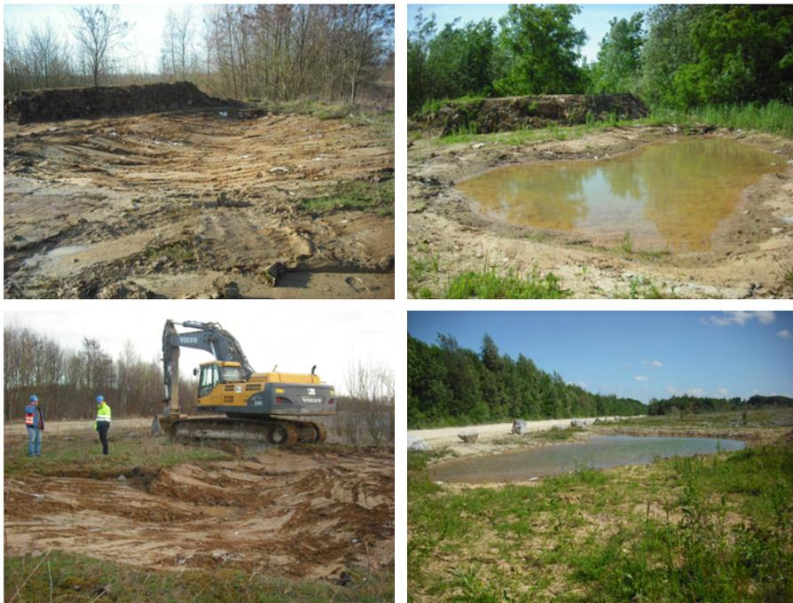
Abb. 7: Anlage von Kleingewässern im März 2010 und wenige Monate später. Trotz Verzicht auf eine künstliche Abdichtung oder Erstbefüllung zeigen die beiden Gewässer seit ihrer Anlage eine zwar schwankende, in der Regel aber kontinuierliche Wasserführung, die ausschließlich über Niederschläge erfolgt.
