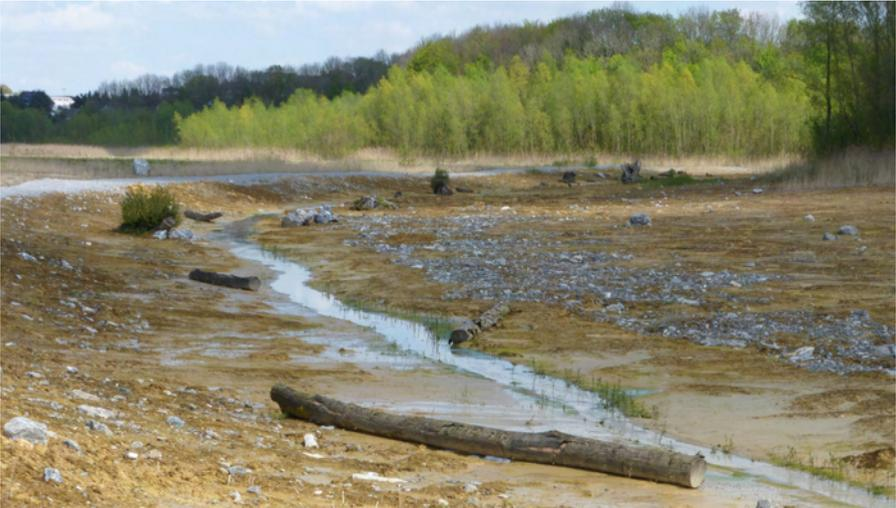
Abb. 9: Mit großem Aufwand mussten die Gefälleverhältnisse auf dem SBE umgekehrt werden, um dem „neuen“ Eignerbach ein in südliche Richtung entwässerndes Bachbett anzubieten (04.05.2016).
